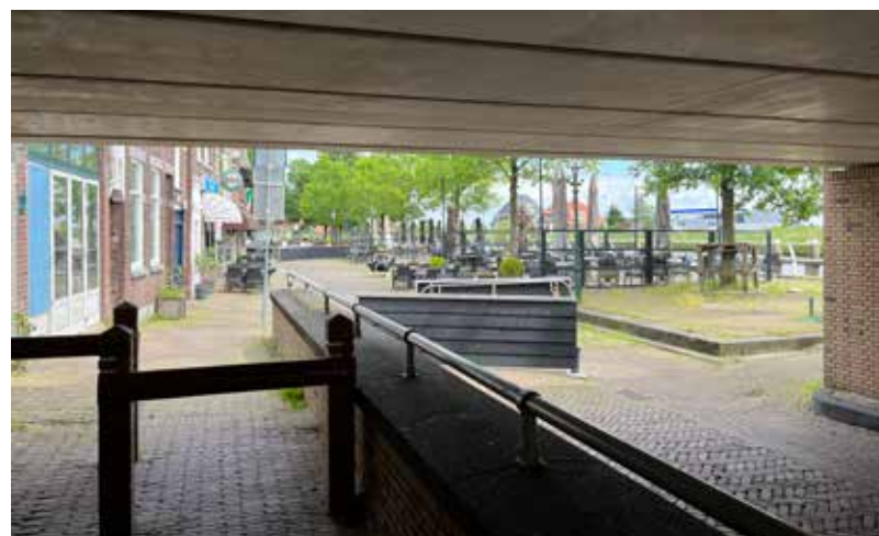
Brugdoorgang: obstakels belemmeren doorgang voetgangers en fietsers.
